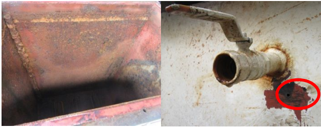
รูปที่ 9 เครื่องช่วยระเหยก่อนปรับปรุง
