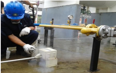
รูปที่ 11 การทดสอบอุปกรณ์จับก๊าซรั่ว
